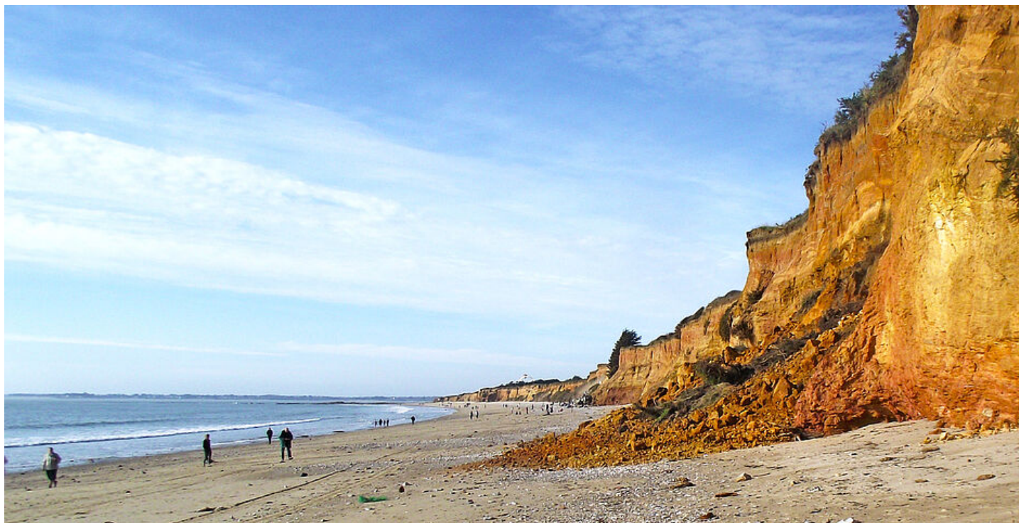
Eboulement classique à la Mine d'Or. Un arrêté municipal interdit le cheminement en pied de falaise afin de prévenir du risque encouru.
