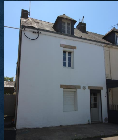
Réhabilitation de la maison Tendron
