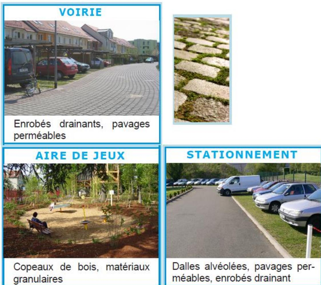
Figure 33 : Photos d'exemples d'alternatives à l'imperméabilisation du sol
