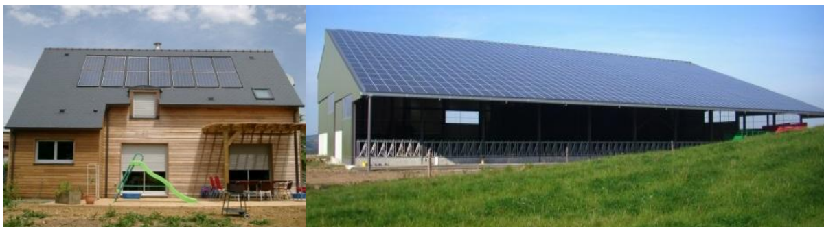
Figure 12 : Exemples de dispositifs photovoltaïques installés sur la toiture d'une maison individuelle (intégration dans la toiture en ardoise) et d'un hangar agricole
